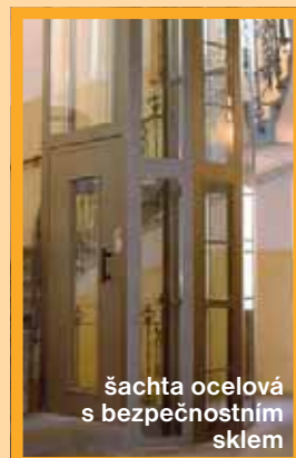
šachta ocelová s bezpečnostním sklem
