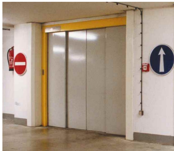
Šachetní dveře 4 dílné automatické centrální
